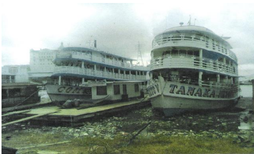
Figura 85. Atracadouro Próximo à Ponte que Interliga os Bairros São Raimundo e Aparecida, sobre o Igarapé São Raimundo
