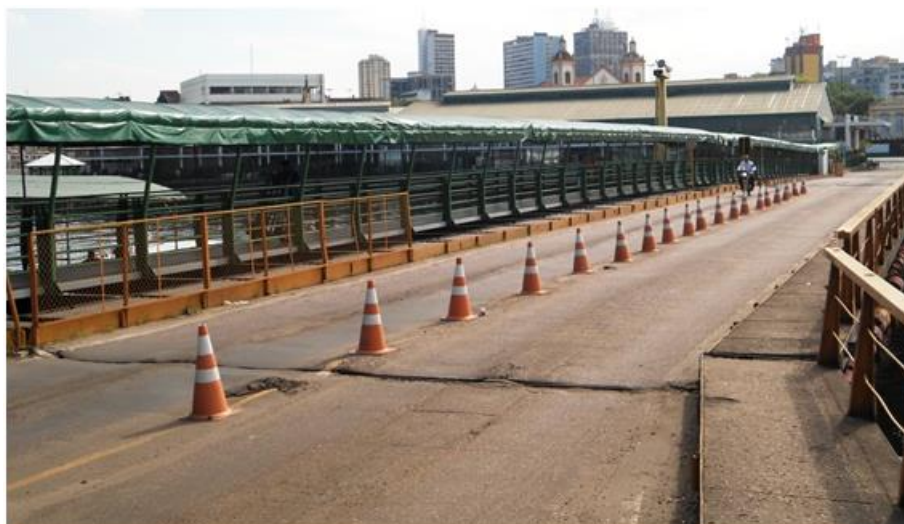
Figura 32. Ponte do Roadway
