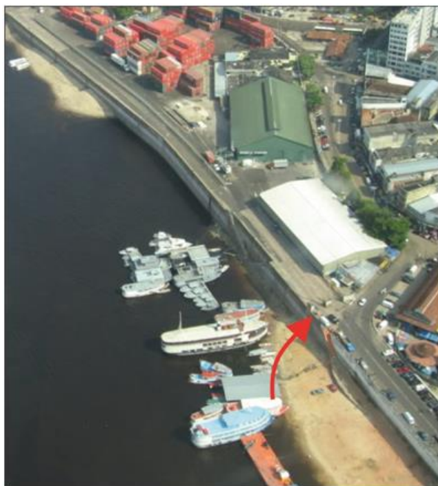
Figura 60. Portão de Acesso ao Porto de Manaus (vista de fora)
