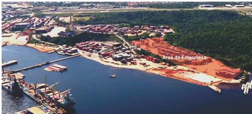
Figura 103. Obras na Área da FRIGOMASA
