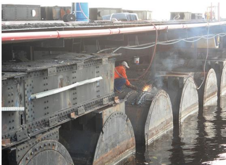
Figura 1. Soldagem nos Flutuantes
