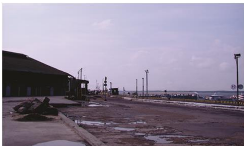
Figura 59. Portão de Acesso ao Porto de Manaus (vista de dentro)
