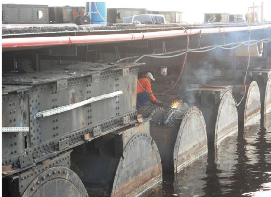
Figura 30. Soldagem nos Flutuantes
