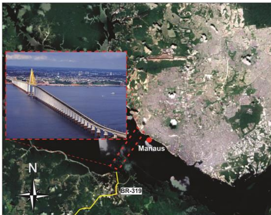
Figura 49. Ponte Rio Negro
