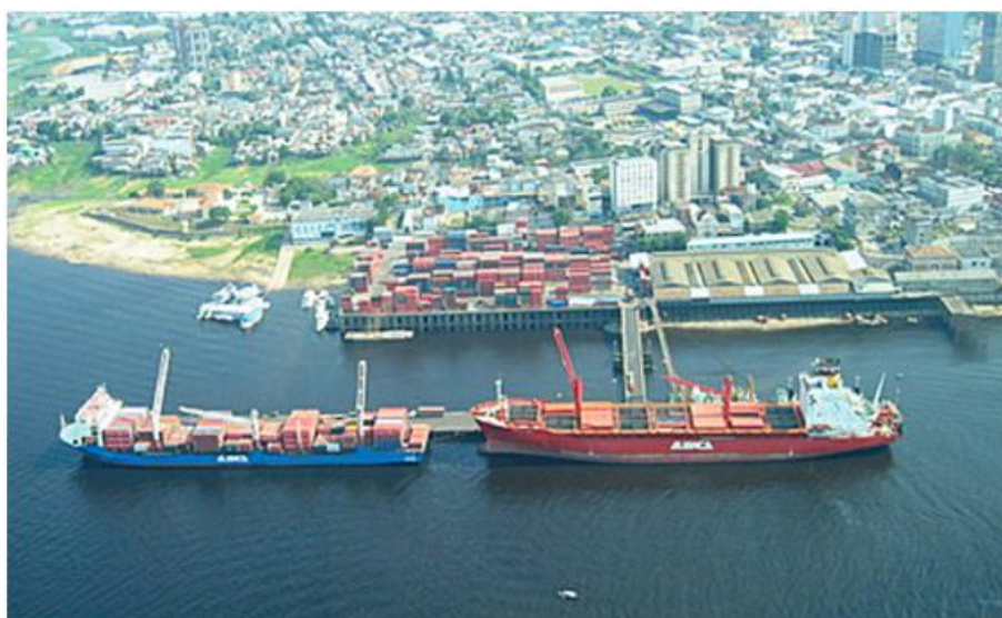
Figura 28. Vista Geral do Cais das Torres em 2007
