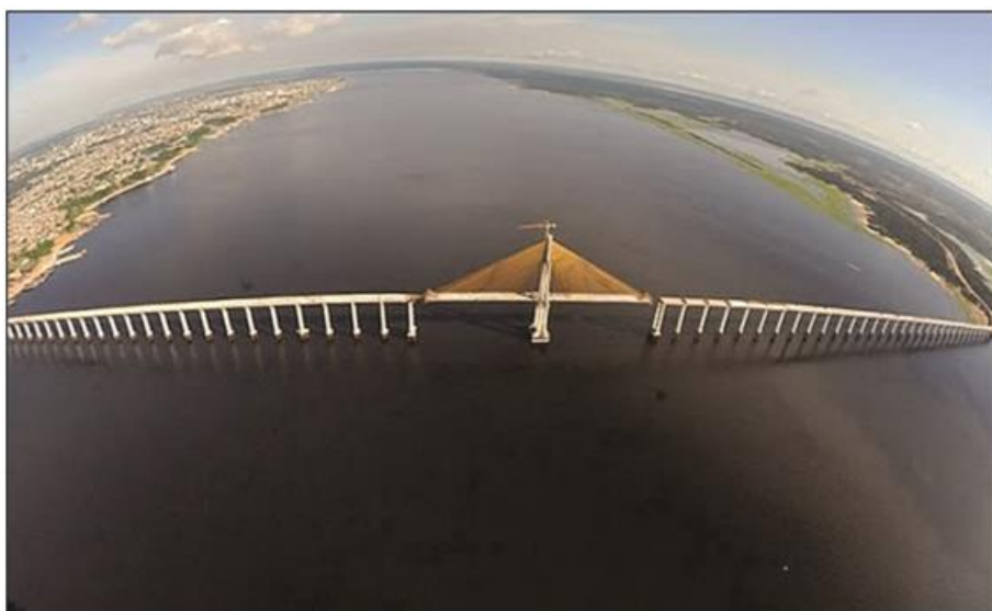
Figura 50. Ponte Rio Negro
