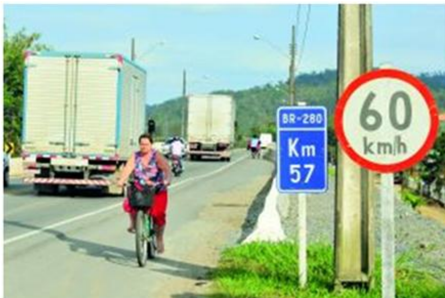
Figura: BR-280 atual em via singela e lote 3 das obras de duplicação pelo DNIT.
