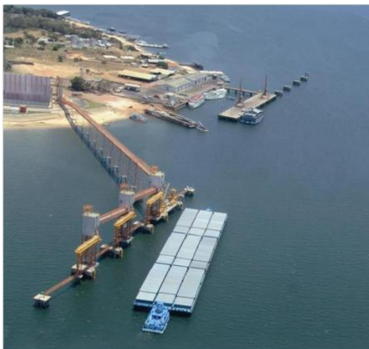
Figura 55. Comboio de Nove Chatas Graneleiras se Aproximando do Terminal da Cargill
