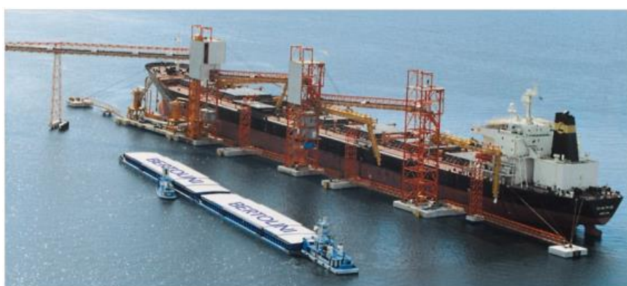
Figura 54. Comboio de Chatas Graneleiras se Aproximando do Berço Interno com Navio Graneleiro Atracado no Berço Externo do Terminal da Cargill
