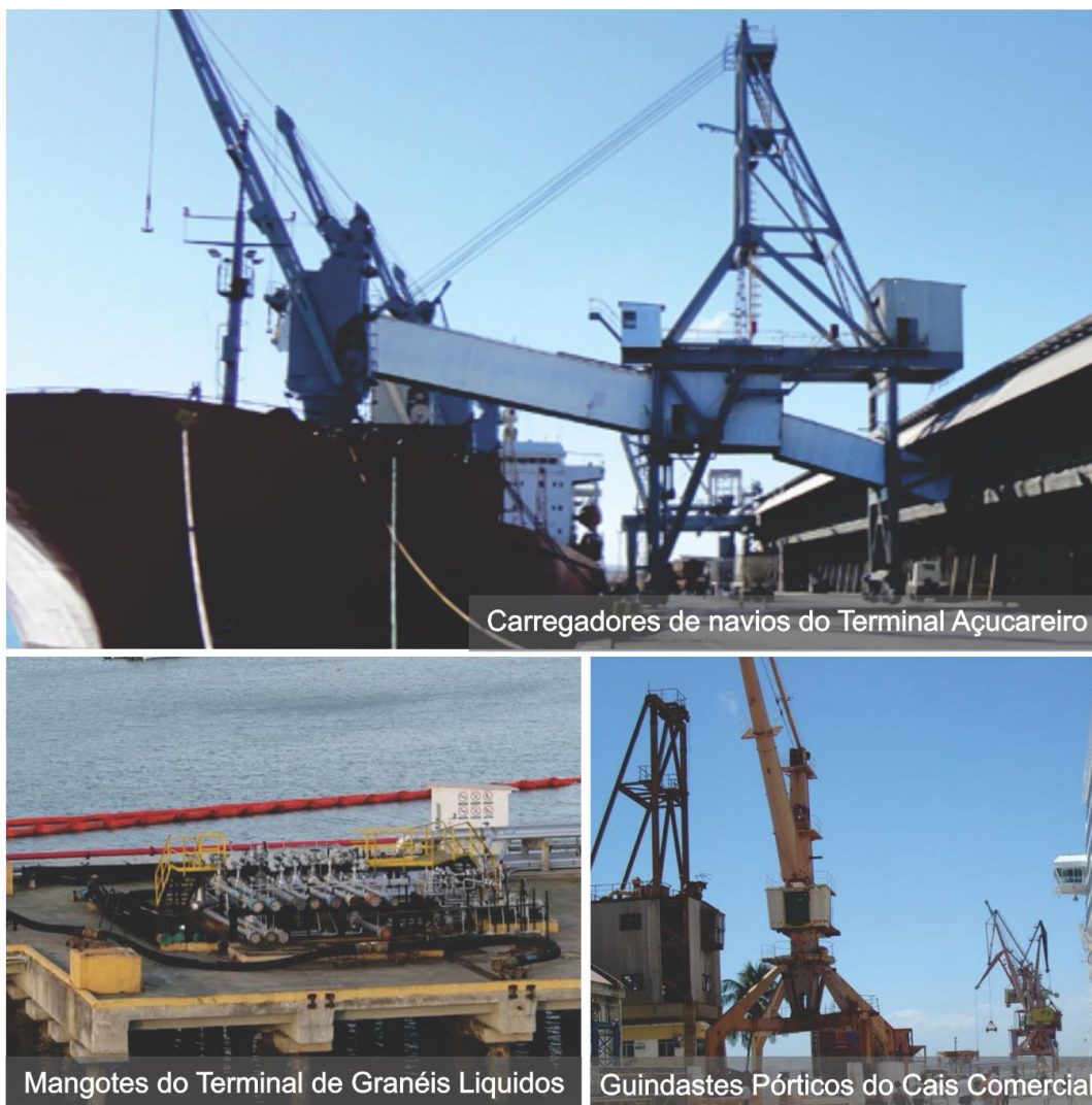
Figura 60. Equipamentos de Cais
