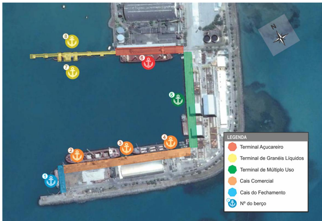
Figura 55. Infraestrutura de Acostagem do Porto de Maceió
