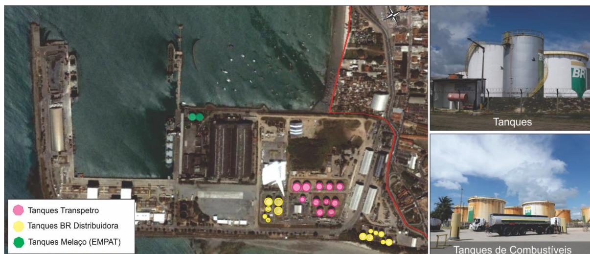
Figura 7. Tanques do Porto de Maceió
