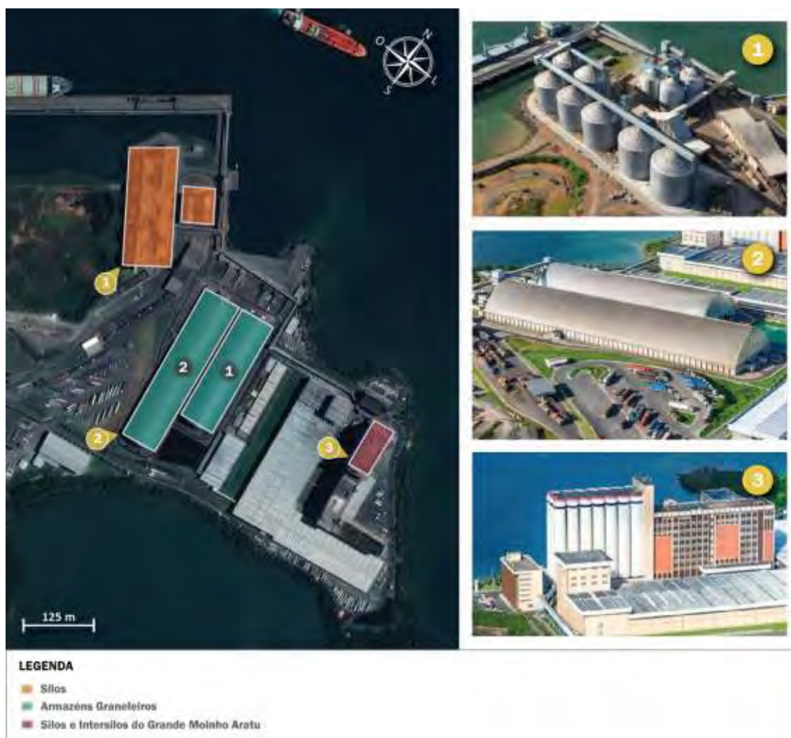
Figura 49 – Estruturas de armazenagem do TPC
