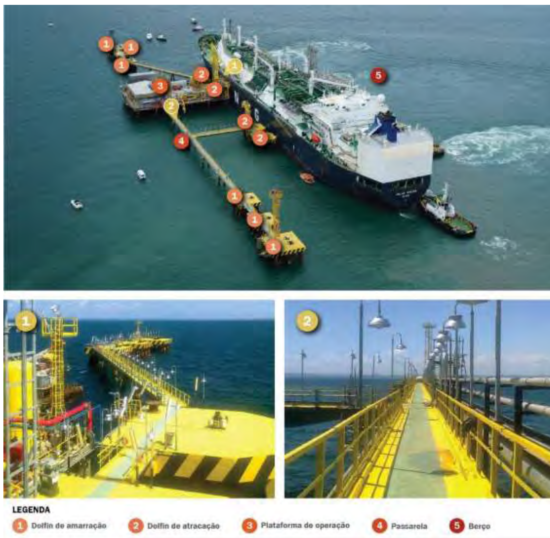
Figura 72 – Infraestrutura de acostagem do TRBA
