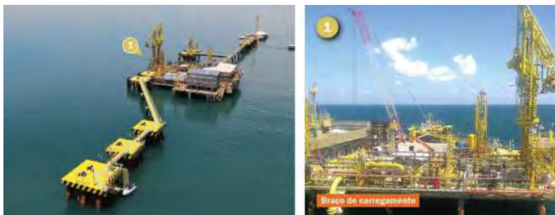
Figura 74 – Braços de carregamento do TRBA
