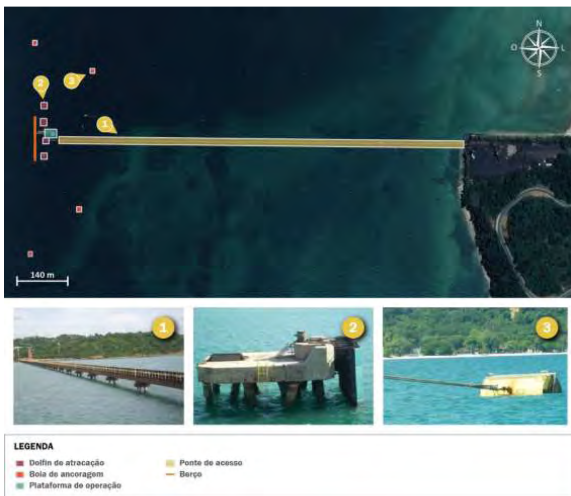
Figura 55 – Infraestrutura de acostagem TUP Gerdau
