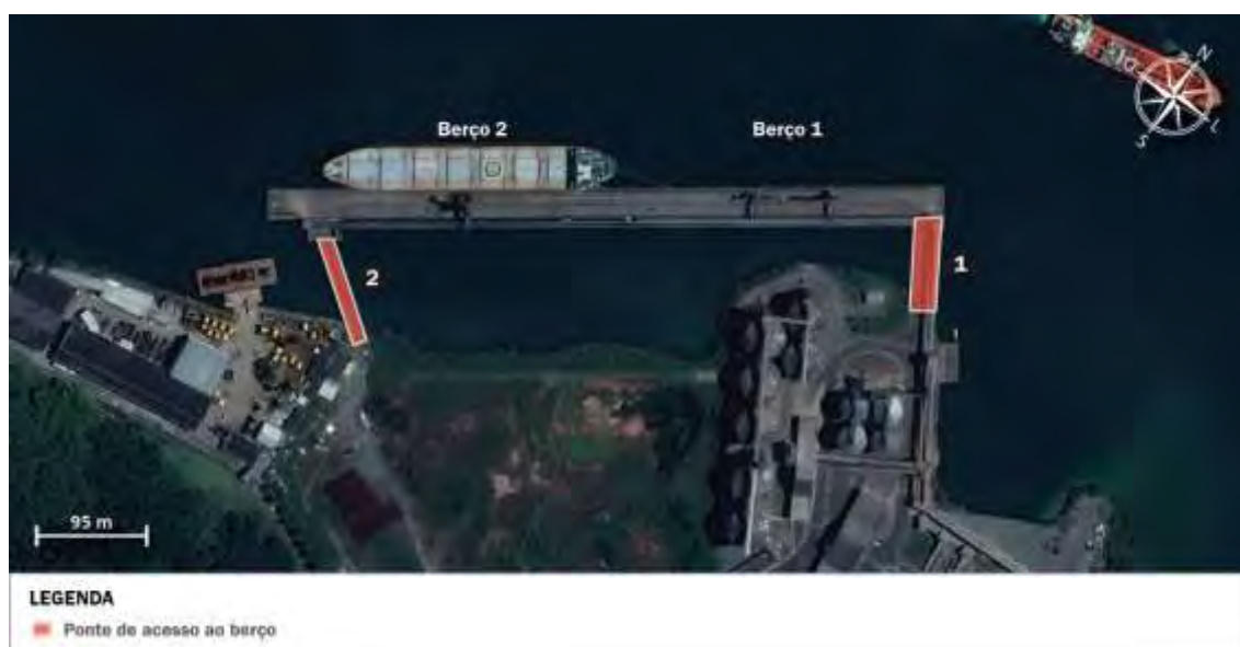
Figura 48 – Estruturas de Acostagem do TPC
