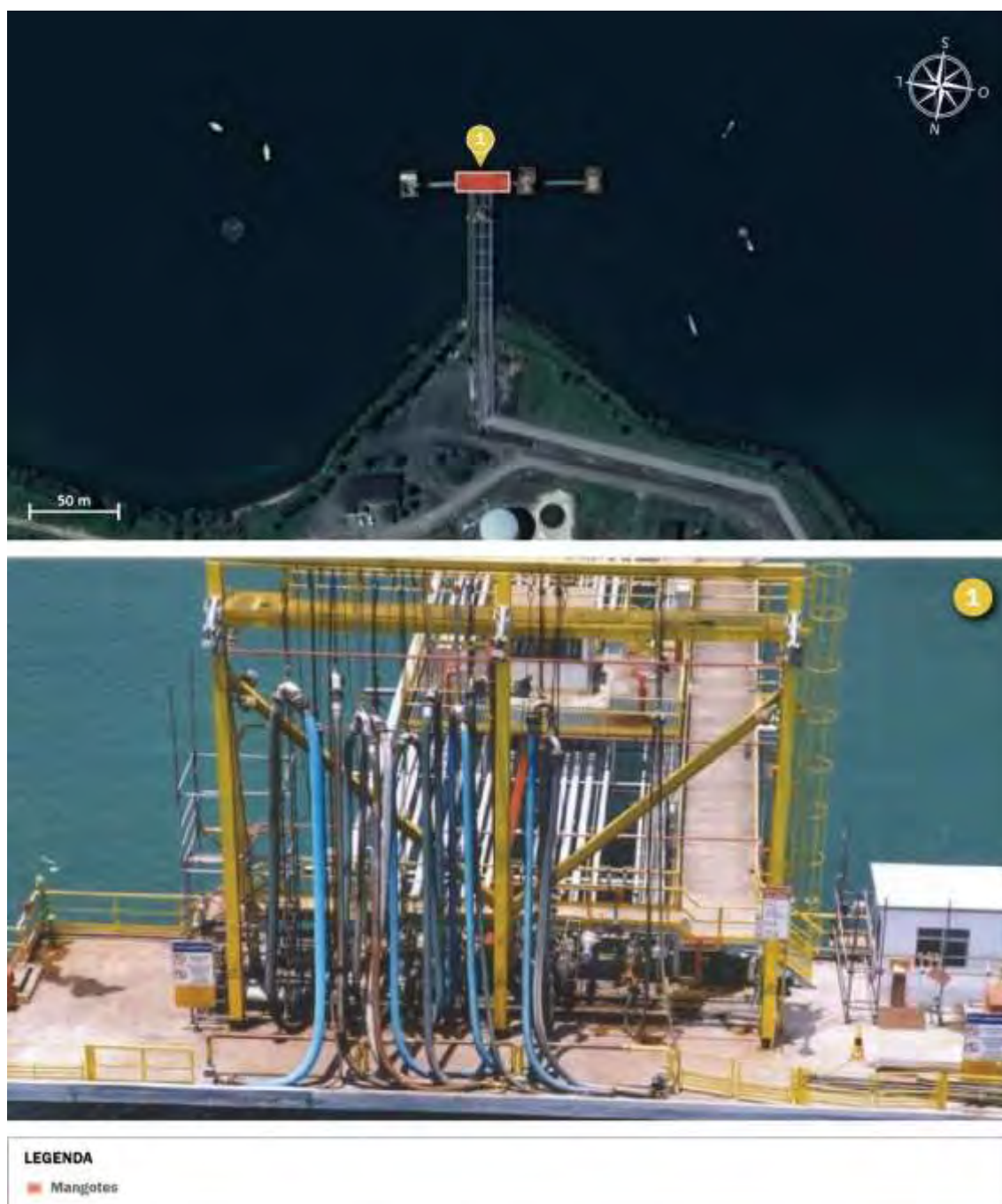
Figura 68 – Conjunto de mangotes do Terminal Marítimo Dow
