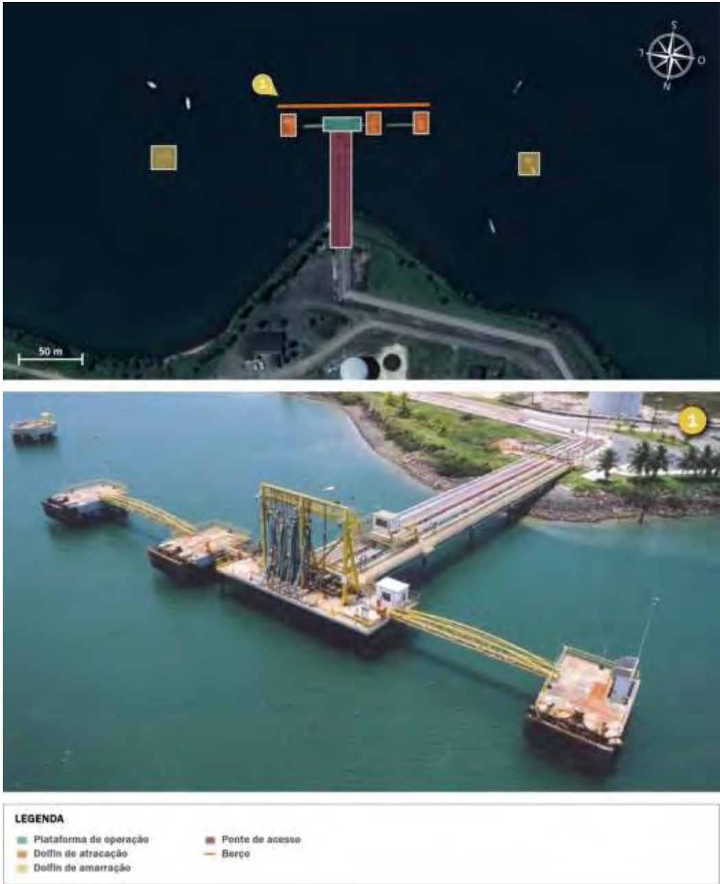
Figura 66 – Infraestrutura de acostagem do Terminal Marítimo Dow Fonte: Google Earth (2017) e Imagem obtida através de aplicação de questionário on-line (2017). Elaboração: LabTrans/UFSC (2018)
