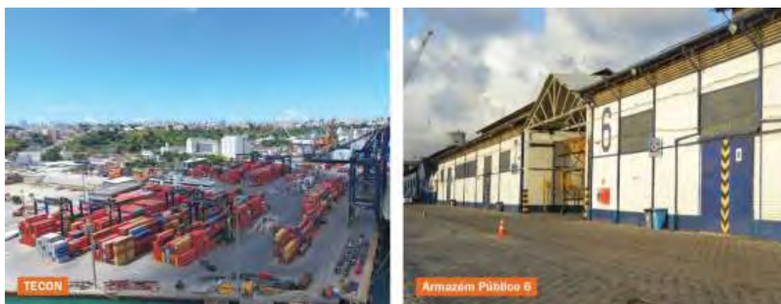
Figura 28 – Instalações de armazenagem do Porto de Salvador
