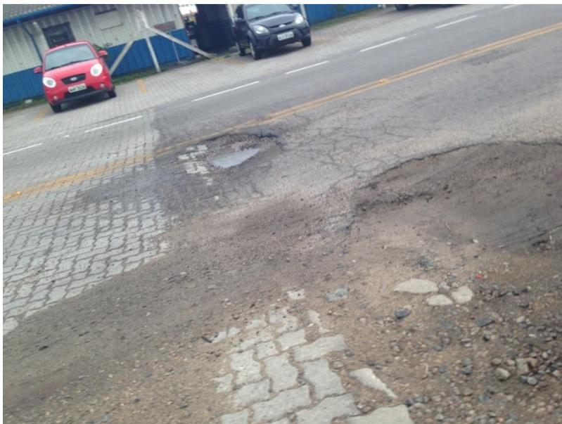
Figura 35 – Presença de buracos e fissuras na VP 3
