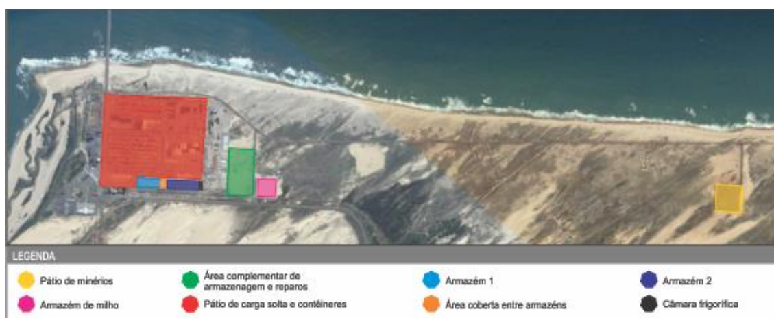
Figura 62. Estruturas de Armazenagem do Terminal Portuário do Pecém Fonte: Google Earth (2014); Adaptado por LabTrans
