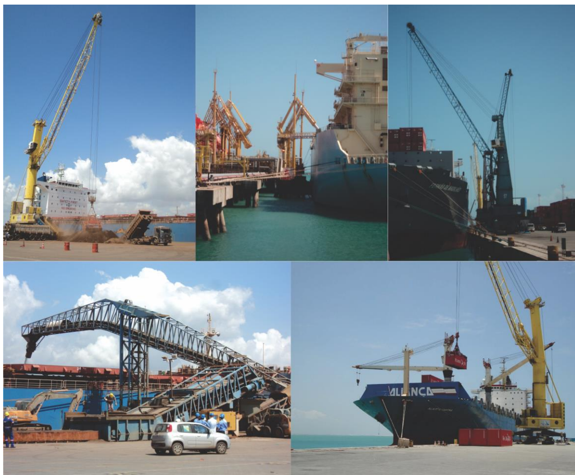
Figura 65. Equipamentos de Cais do Terminal Portuário do Pecém
