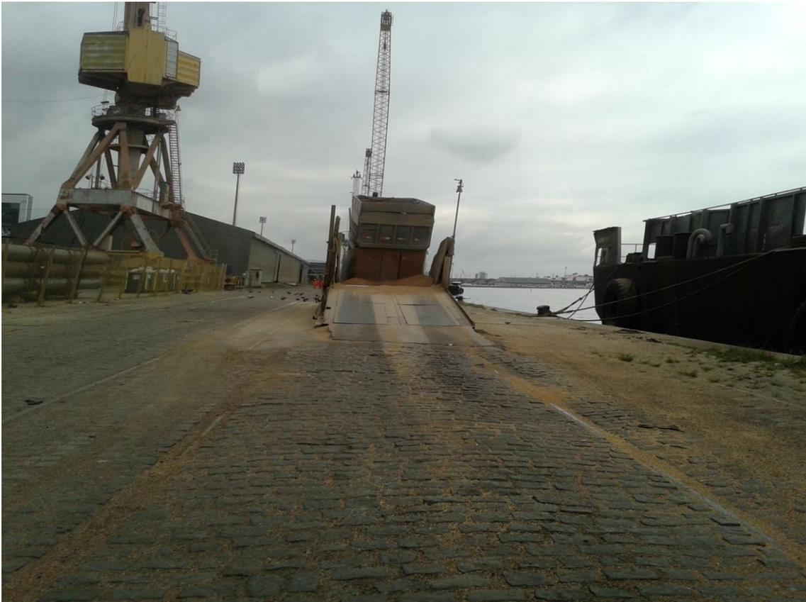
**Figura 68.** Pavimento em Paralelepípedos – Cais São Cristóvão
