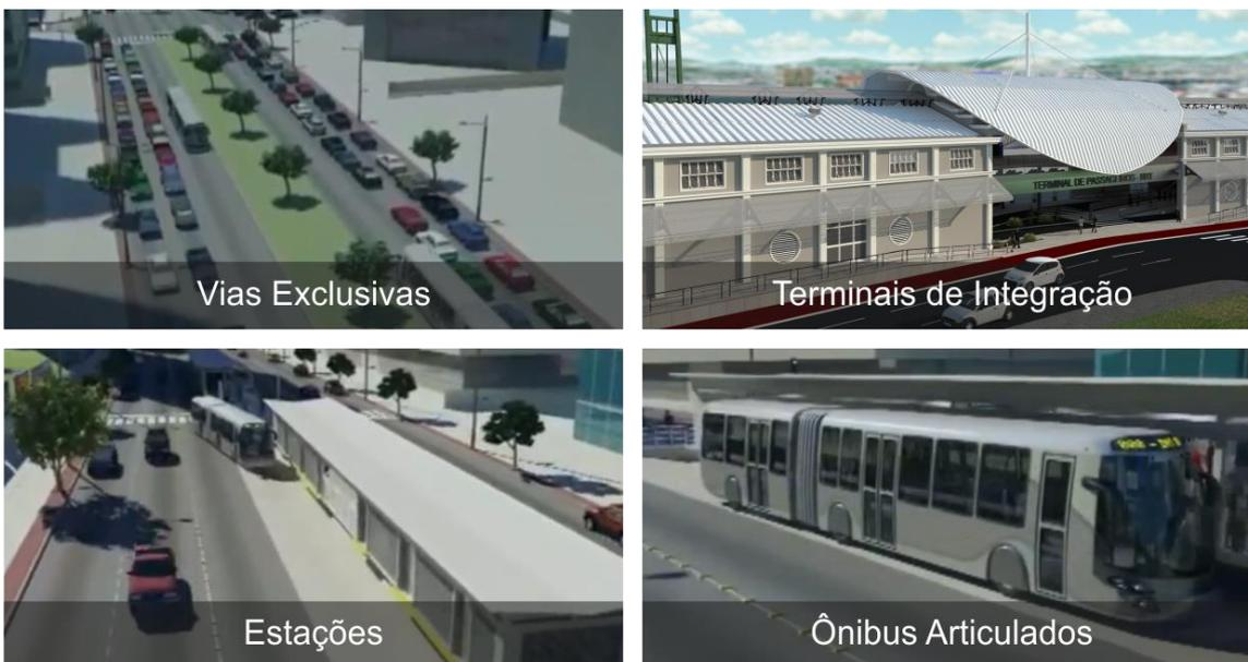
**Figura 125.** Elementos Característicos do Sistema BRT
