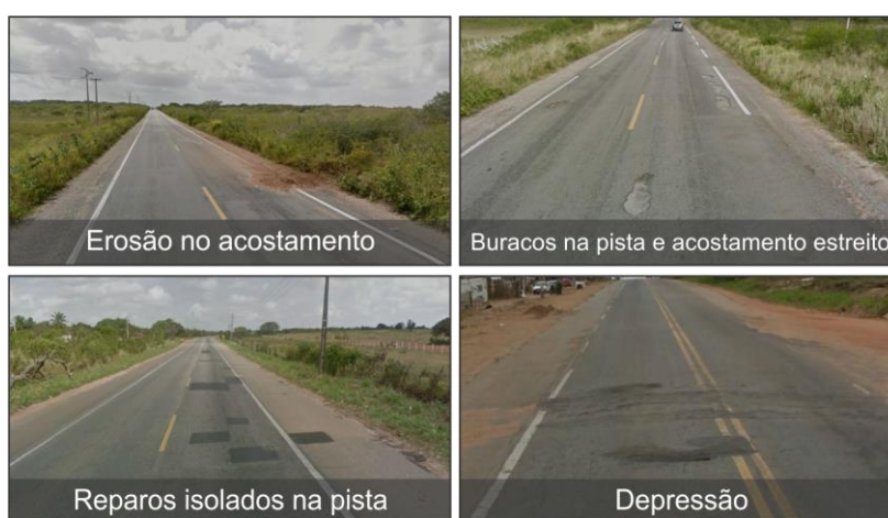
Figura 60. Condições dos acostamentos da BR-406 no estado do Rio Grande do Norte
