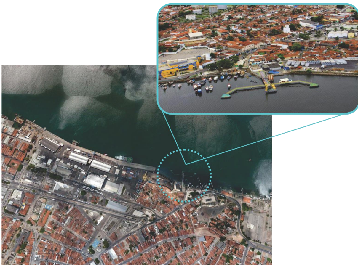
Figura 38. Terminal desativado da Transpetro
