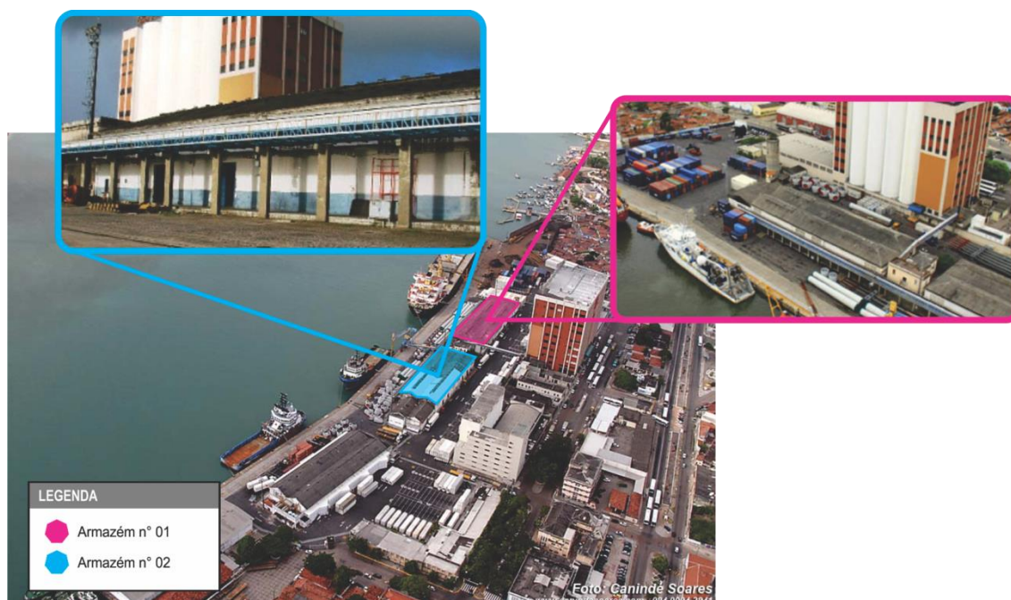
Figura 43. Armazéns 01 e 02 do Porto de Natal
