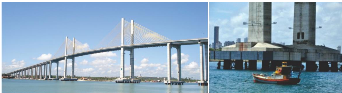
Figura 81. Ponte Newton Navarro Ainda Sem Proteção
