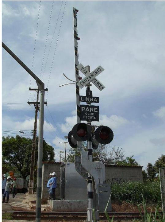
**Figura 73.** Sistema de proteção em passagem de nível – sinalização e alarme
