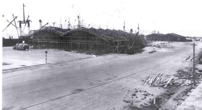
Figura 57. Construção dos Armazéns A-3 e A-4
