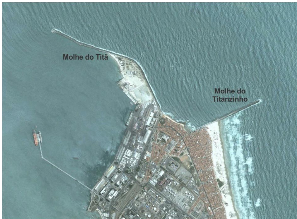
Figura 1. Obras de Abrigo do Porto do Mucuripe
