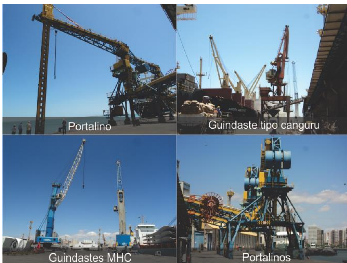
Figura 74. Equipamentos de Cais do Porto do Mucuripe
