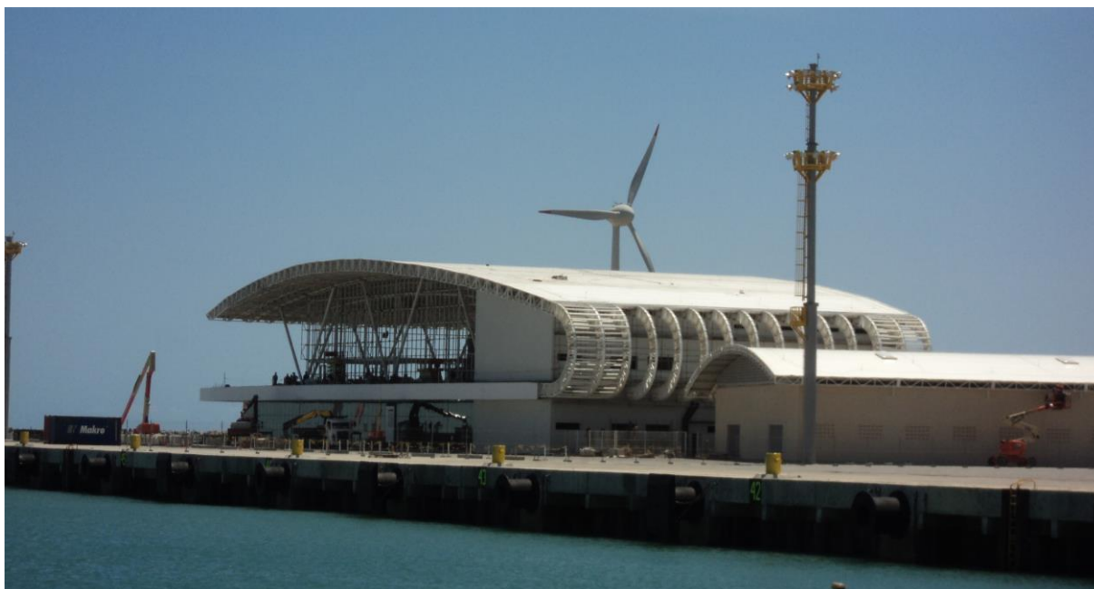
Figura 67. Terminal de Passageiros do Porto do Mucuri
