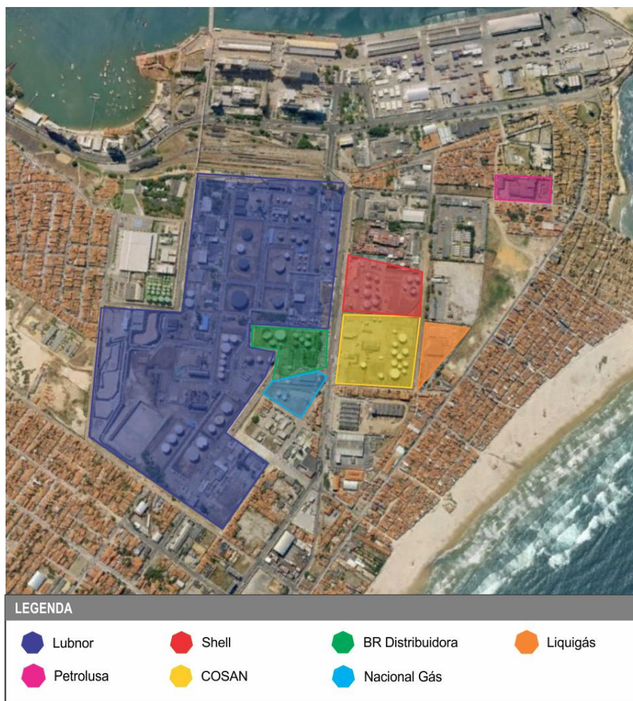
Figura 73. Tanques de Armazenagem do Porto do Mucuripe
