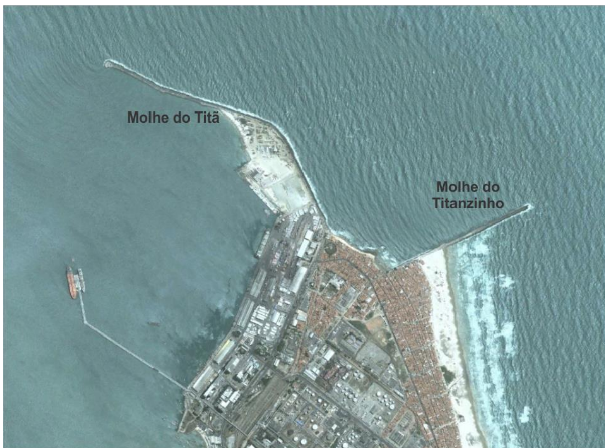
Figura 58. Obras de Abrigo do Porto do Mucuripe
