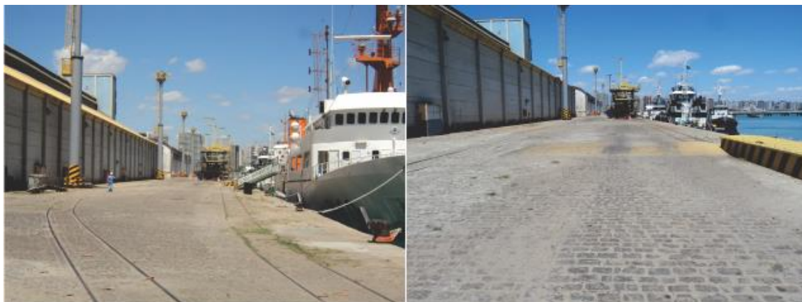
Figura 3. Trecho 2 – Berços 103, 104 e 105 - do Porto do Mucuripe
