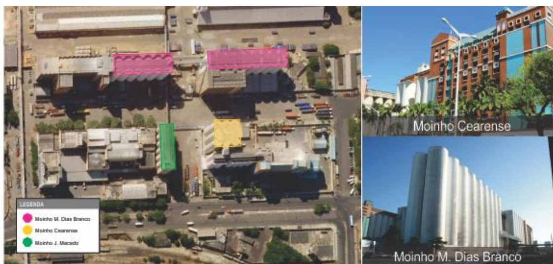
Figura 10. Silos do Porto do Mucuripe
