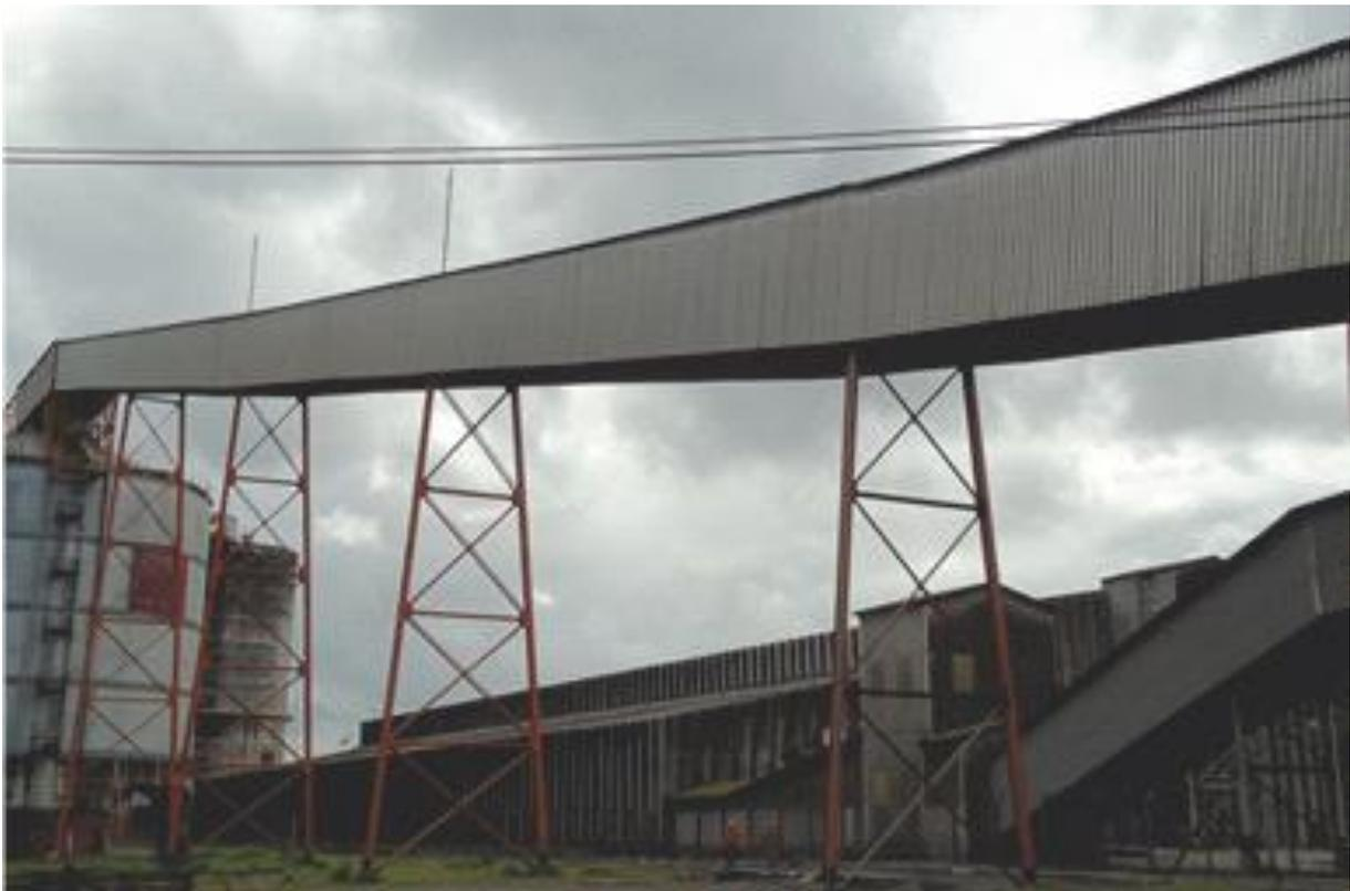
**Figura 8.** Ligação do Silo com o Píer I do TGS do Porto de Aratu-Candeias, através de Correia Transportadora
