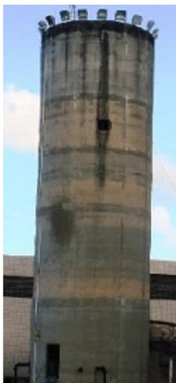
Figura 32 - Castelo d'água capacidade 100 m<sup>3</sup>
