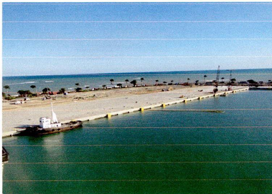
Foto 2.5 – Detalhe do Cais de Múltiplo Uso
