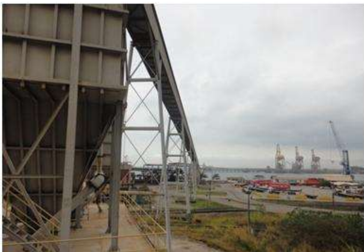
Figura 17 - Transportador de correia
