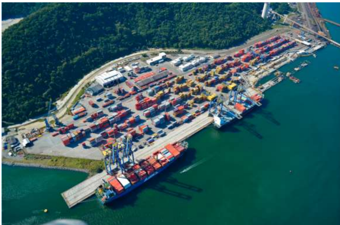
Figura 28 - Foto aérea da área 1 Sepetiba Tecon
