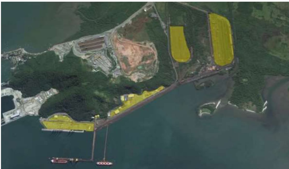
Figura 115 – Imagem aérea das áreas de armazenagem
