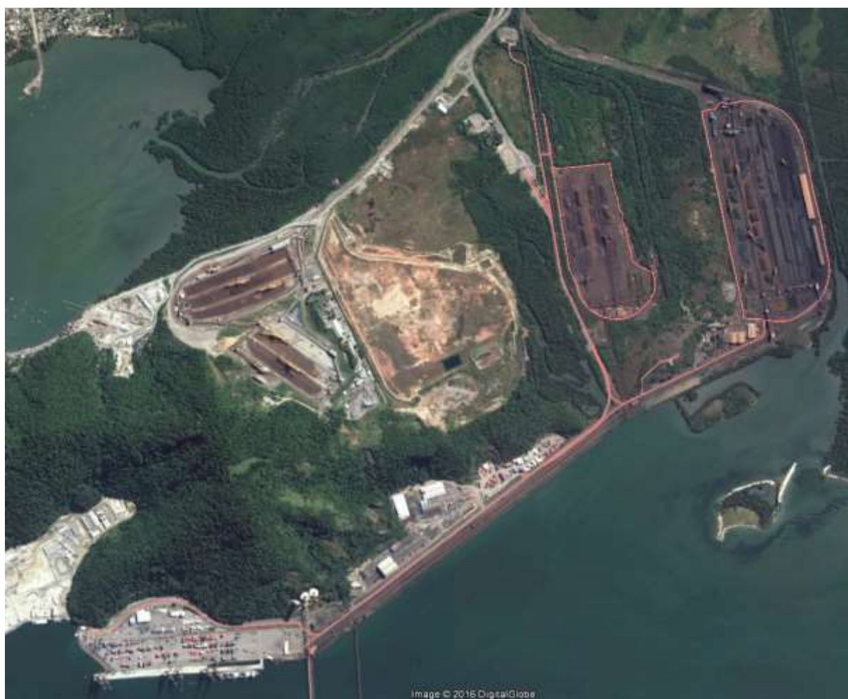
Figura 51 – Vias rodoviárias no Porto de Itaguaí
