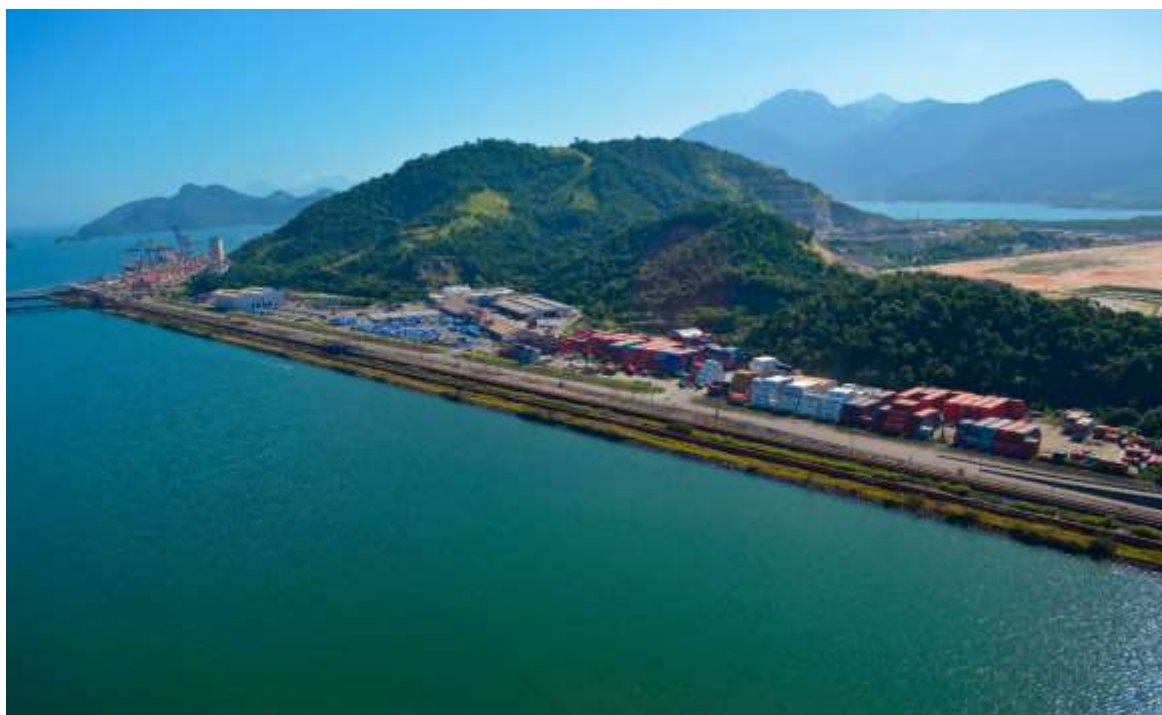
Figura 29 - Foto aérea da área 2 Sepetiba Tecon
