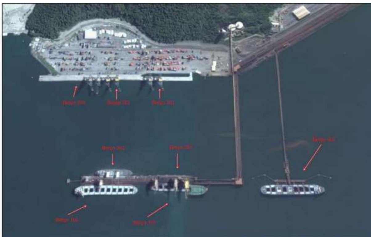
Figura 7 - Instalações de Acostagem
