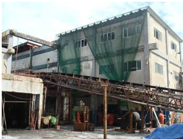
Figura 50 - Recuperação e reforma do prédio sede
