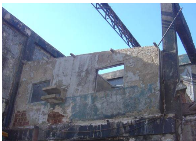
Figura 47 - Recuperação e reforma do prédio sede
