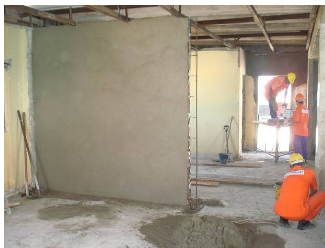
Figura 48 - Recuperação e reforma do prédio sede
