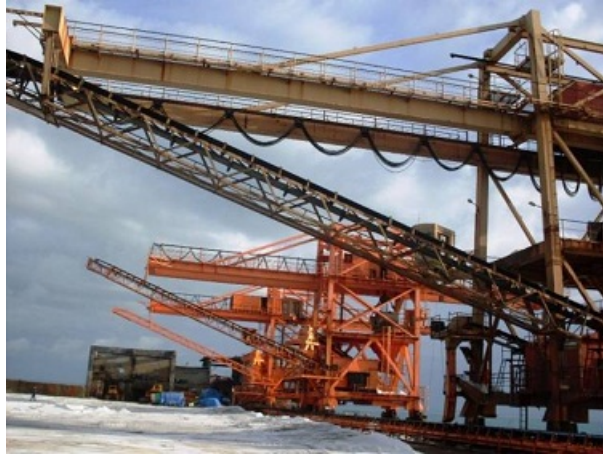
Figura 35 - descarregadores de barcaça
