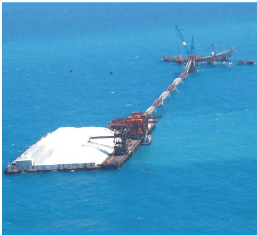
Figura 1 - Vista aérea do Terminal Salineiro de Areia Branca
