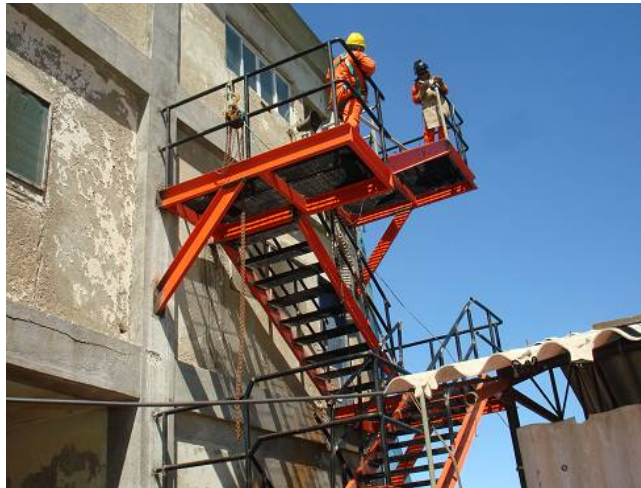
Figura 49 - Recuperação e reforma do prédio sede
