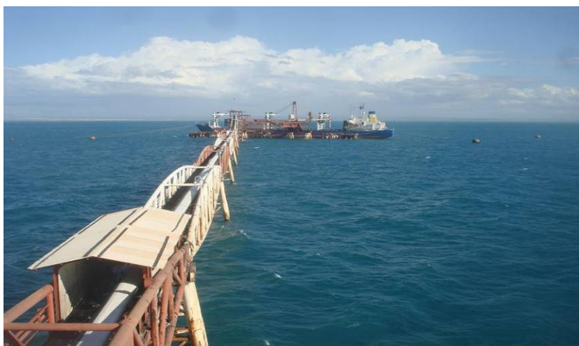
Figura 24 - Movimentação do sal pelas esteiras até os navios
