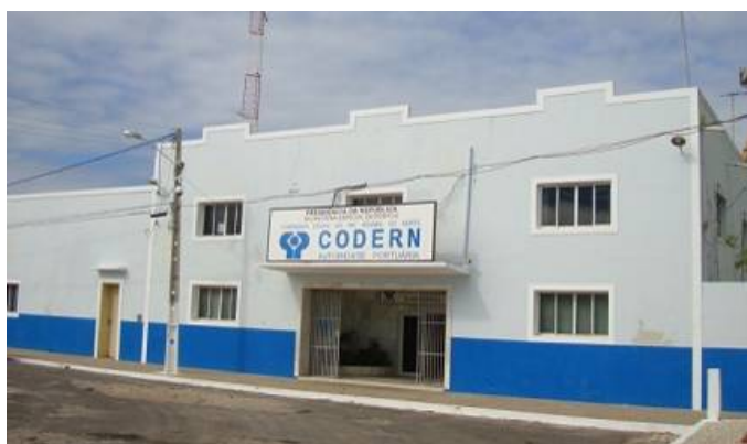
Figura 3 - Sede da Gerência Administrativa do Terminal Salineiro
