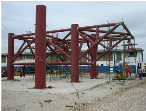
Figura 53 - Execução da obra - etapa em terra
