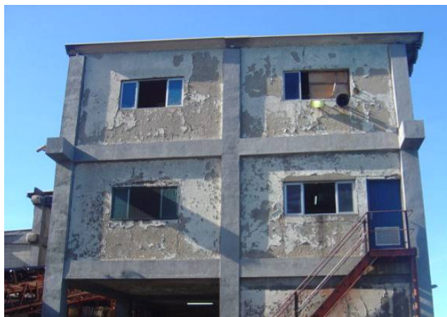
Figura 45 - Recuperação e reforma do prédio sede
