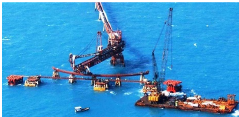
Figura 37 - Obra sendo executada
