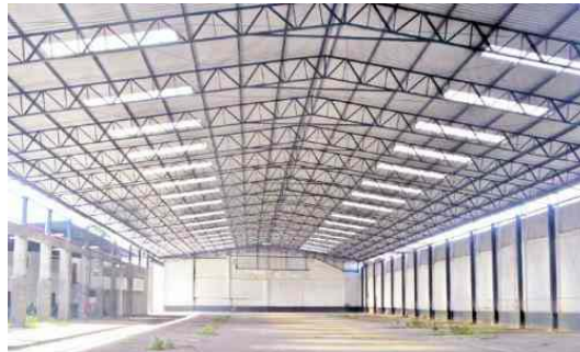
Figura 44 - Galpão em chapa de aço
