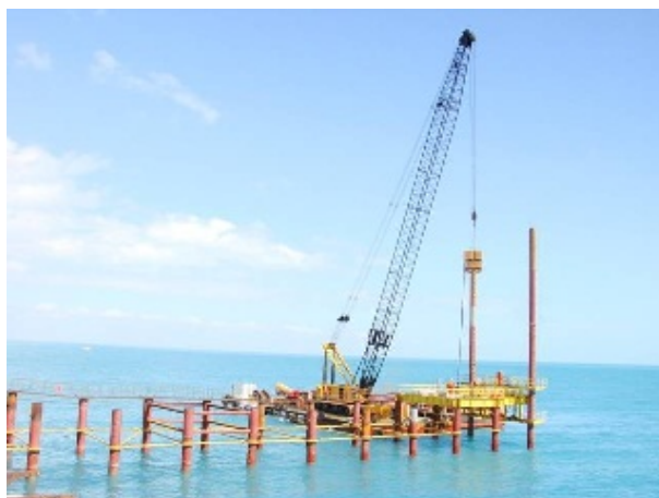
Figura 56 – Execução da obra - etapa em alto mar
