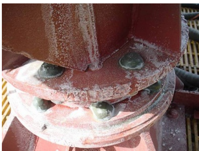
Figura 43 - Obra de recuperação do CN, DH e TT
