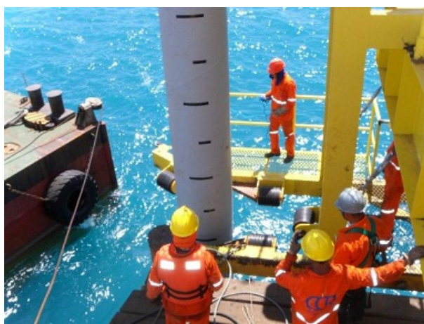
Figura 57 – Execução da obra - etapa em alto mar
