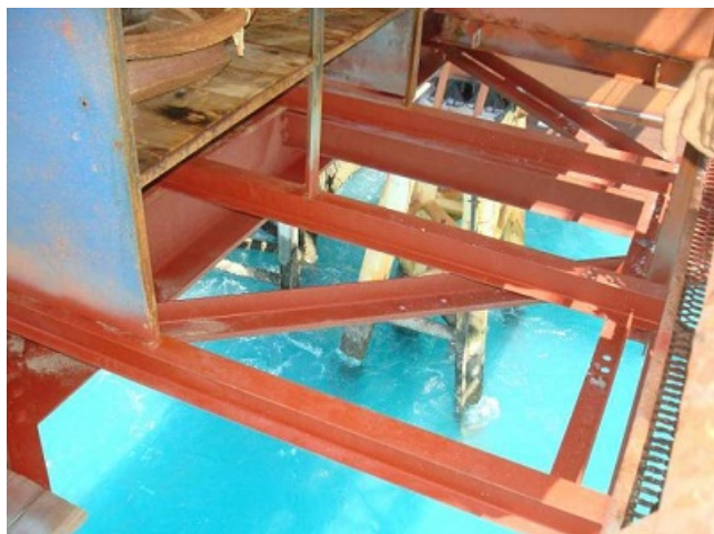
Figura 41 - Obra de recuperação do CN, DH e TT
