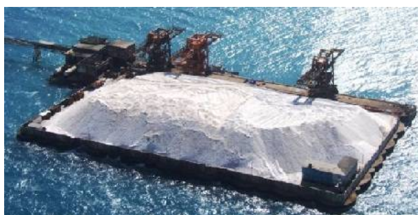
Figura 12 - pátio destinado ao armazenamento de sal
