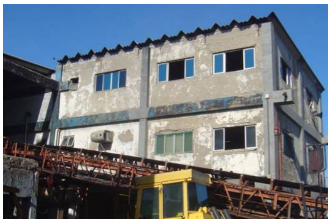
Figura 46 - Recuperação e reforma do prédio sede
