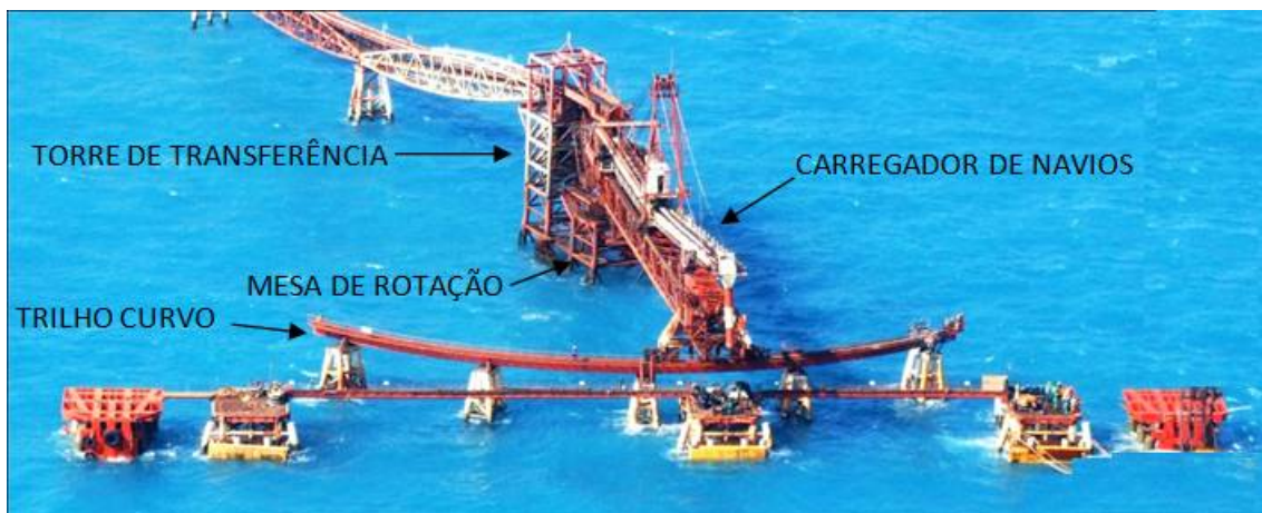
Figura 31 - Estruturas/equipamentos utilizados na movimentação de sal
