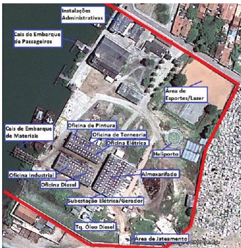
Figura 15 - Vista aérea das instalações da GERTAB localizada em Areia Branca
