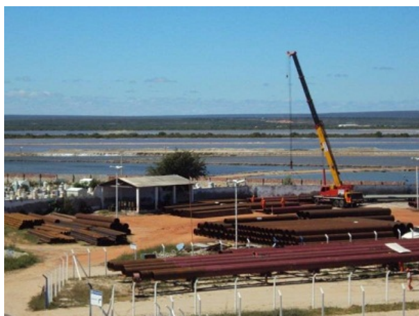
Figura 54 - Execução da obra - etapa em terra
