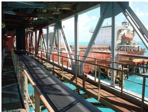
Figura 39 - Obra de recuperação do CN, DH e TT
