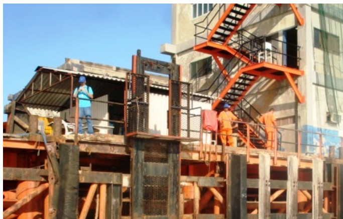
Figura 13 - Acesso de Pessoal ao Terminal Salineiro
