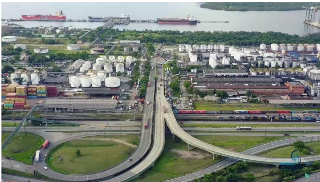
Figura 39 - Viaduto de acesso ao porto, na região da Alamoia (Fonte: SPA).
