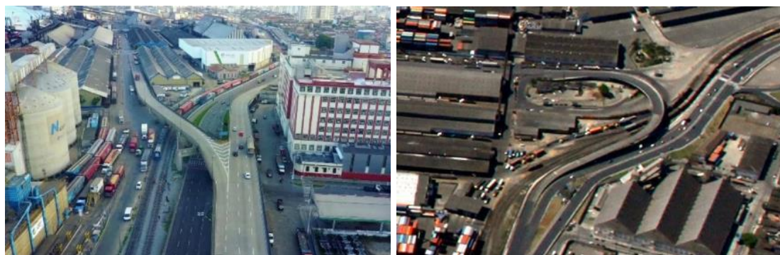
Figura 41 - Viadutos de entrada e saída dos terminais do Outeirinhos (Fonte: SPA).
