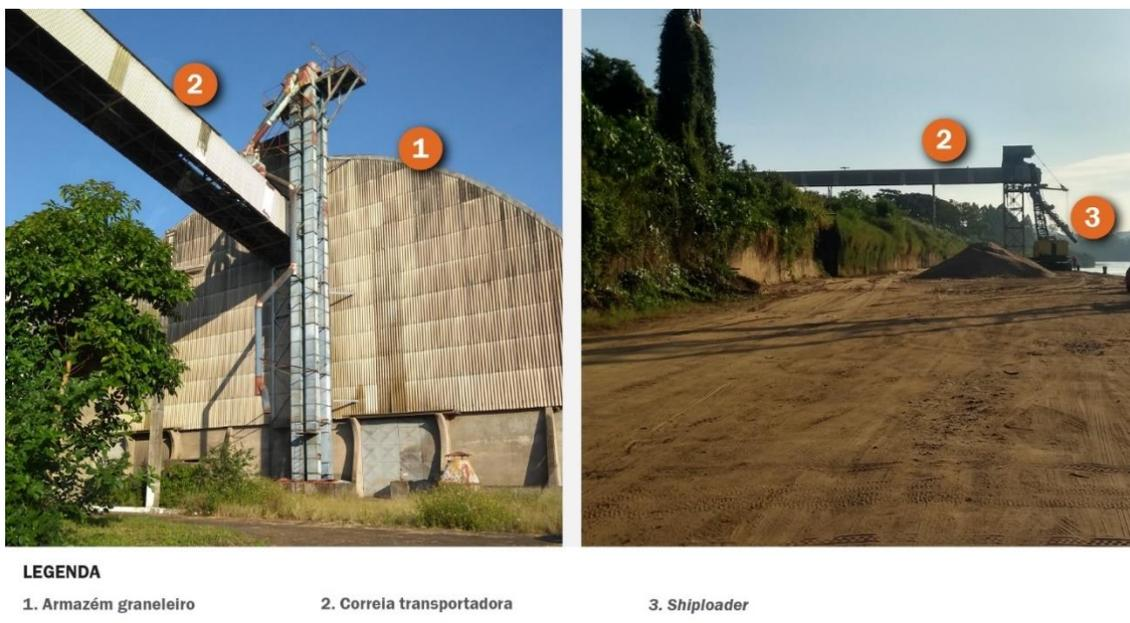
Figura 11 – Correias transportadoras do Porto Fluvial de Estrela
