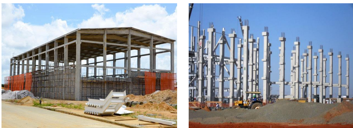
Figura 3.4 – Ilustrações de estruturas pré-moldadas, pré-fabricadas para armazéns/galpões.
