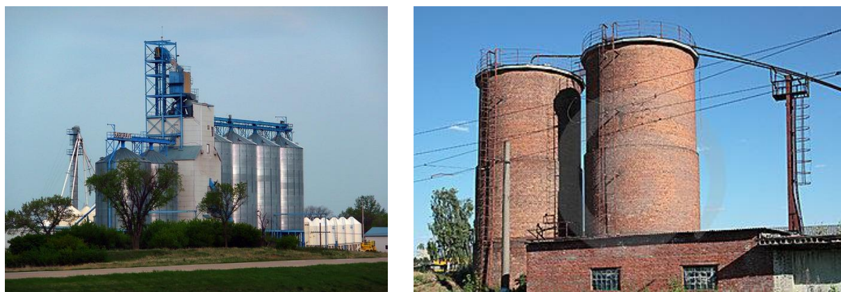
Figura 3.8 – Ilustrações de silos metálicos e de alvenaria.
