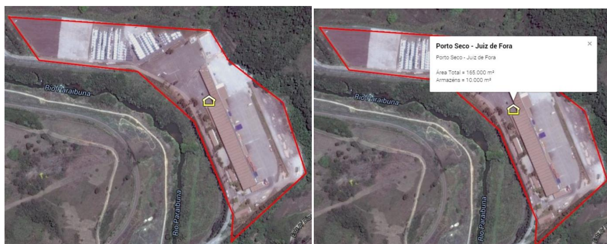
Figura 3.19 – Porto Seco de Juiz de Fora (Zona da Mata) – Administrador Multiterminais Alfandegados do Brasil Ltda 53 .
